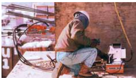
Применение насоса модели PE60 для создания предварительного напряжения арматуры
